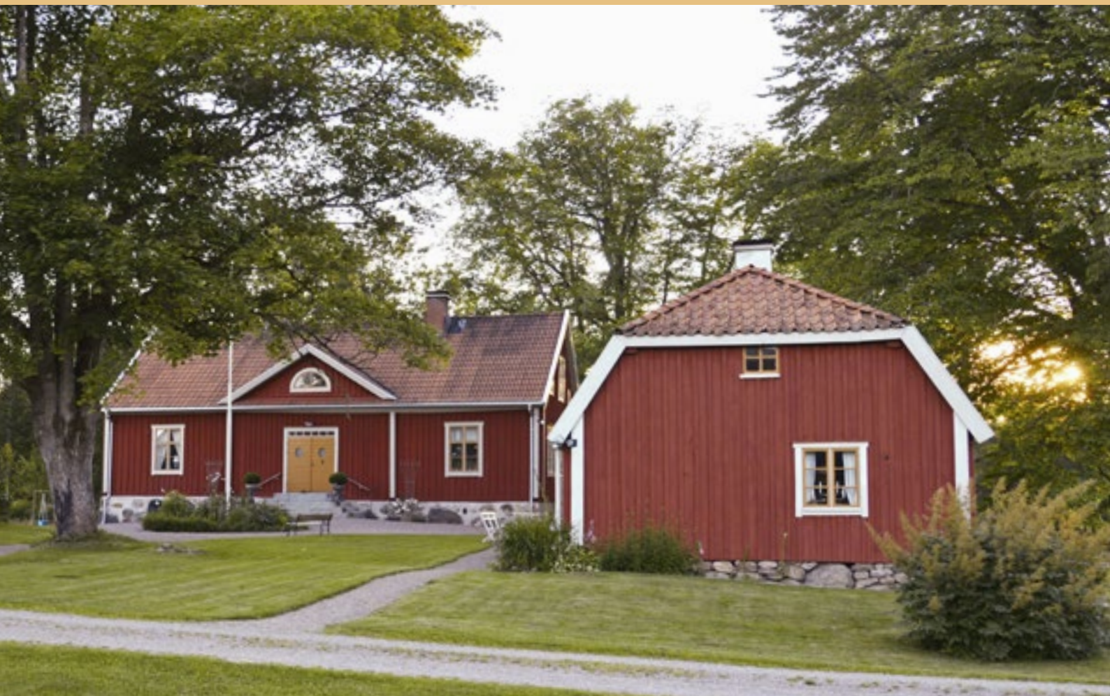
Stora Kölabodas karaktärsbyggnad och sätesstuga från öst.
