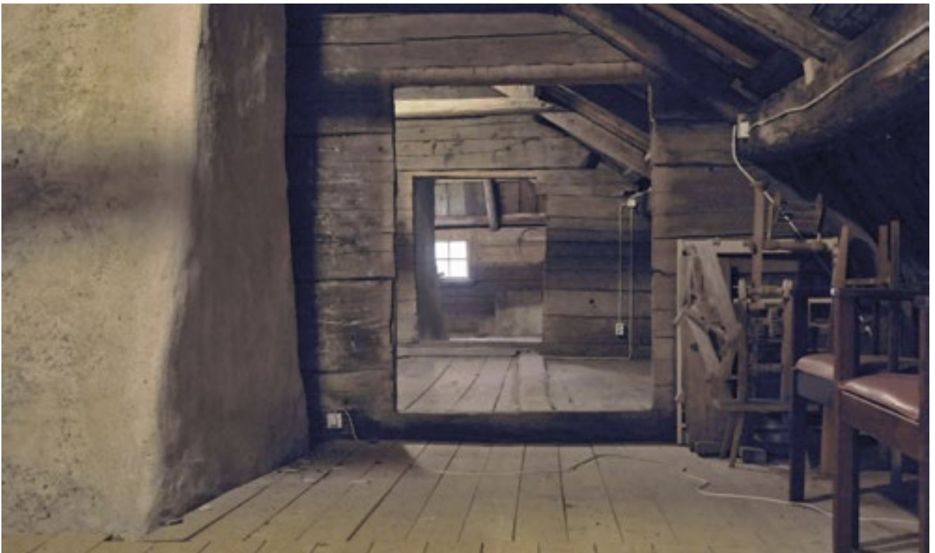
Sätesstugans vind, med skorstenen till den stora spisen till vänster. Timmerstommen och takkonstruktionen ger intryck av att ha blivit uppförd i en hast.
