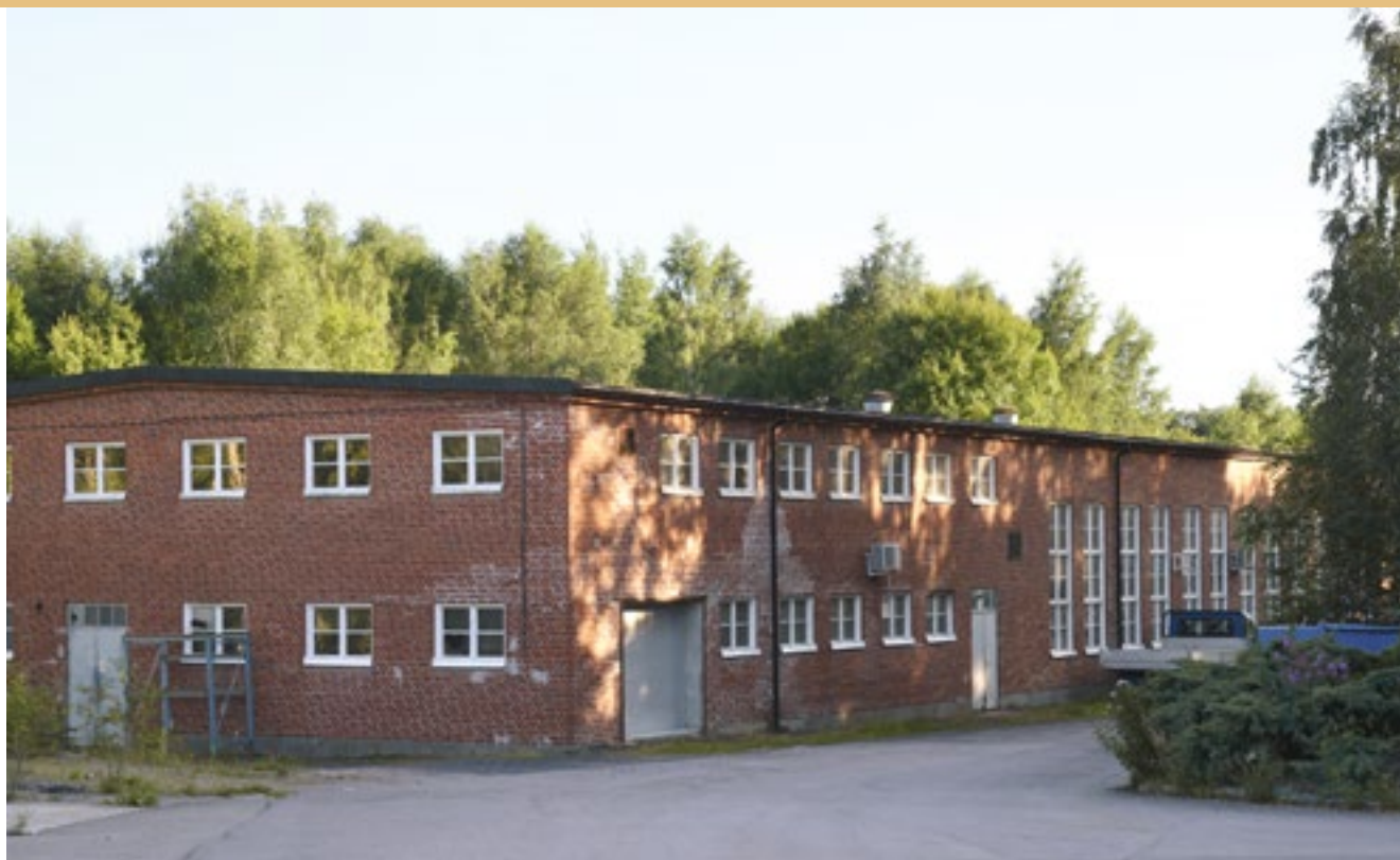
Bevarad fabriksbyggnad från tiden då Strömsnäs Bruk AB drev sulfatfabriken i Delary.
