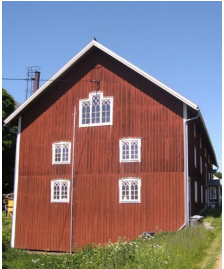
Såg och spannmålmagasin
