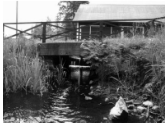
Nedströms den stora dammen i Åminne.
