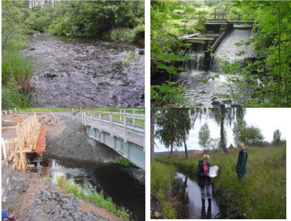
Figur 9. Exempel på företeelser som noteras vid en biotopkartering. Överst t v en inte alltför starkt strömmande grund sträcka, lämplig som uppväxtlokal för öring. Överst t h nedströms en damm som utgör definitivt vandringshinder för fisk. Nederst t v: en ny bro byggs över Tidan. Samtliga tre bilder från Tidan. Nederst t h fältkartering av Bäck från Bestorpasjön, Lagans avrinningsområde. Foto Maria Carlsson och Yvonne Liliegren.
