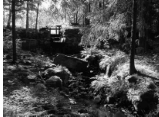
Nedströms dammen norr om Ånestorp.
