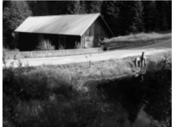
Bro över Sågbäcken vid damm.
