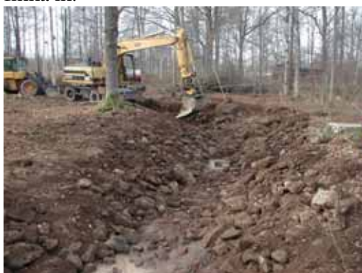
Till vänster: Under arbetet med att gräva ur bäckfåran visade det sig att terrängen var mycket blockrik. Till höger: Omlöpets utflöde nedströms vandringshindret Mela kvarn.
