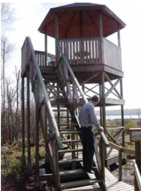
Nybyggt fågeltorn med utsikt över Anebysjön.
