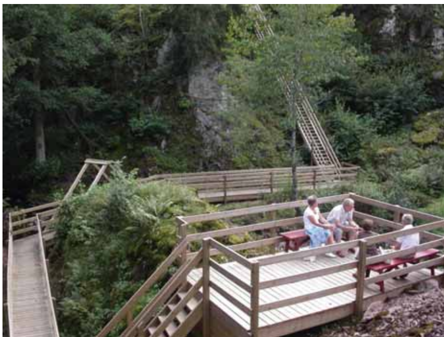
Den som tar sig ner för den långa trappan får en välbehövlig paus på plattformen och kan samtidigt titta på vattenfallet. Foto: Torbjörn Aronsson
