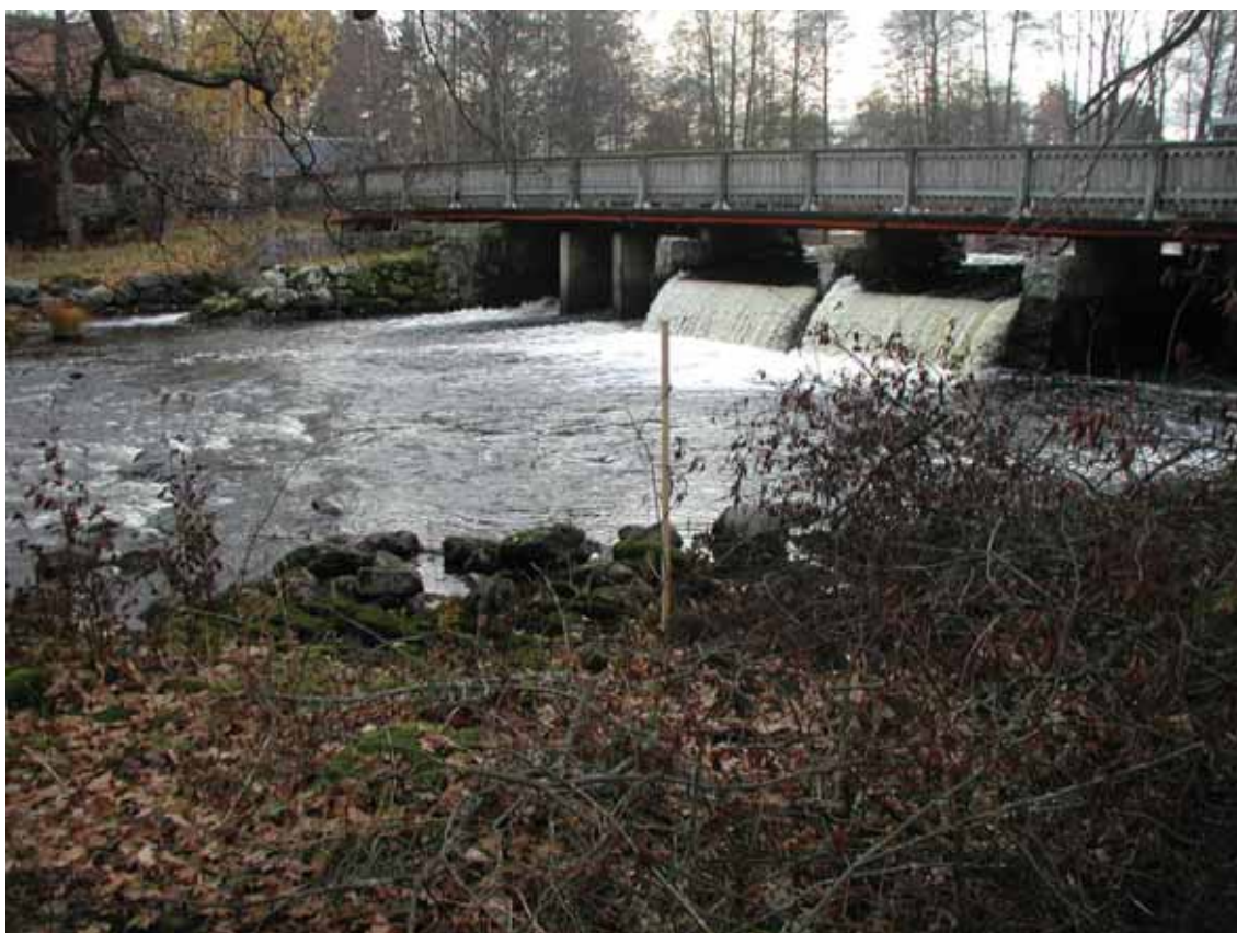
Hålldammen Mela kvarn är ett tydligt vandringshinder i Emåns huvudfåra. Stakkäppen i förgrunden markerar fiskvägens tänkta utflöde.
