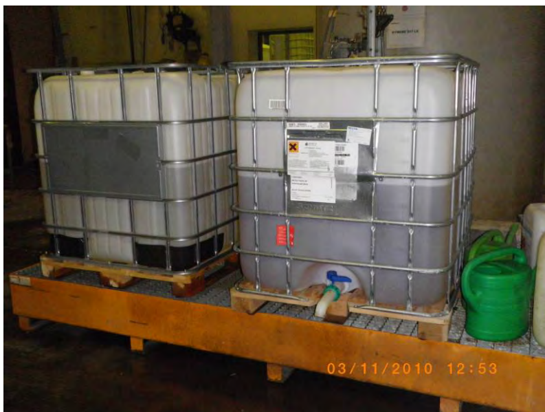
Bild 6: Tankar som visserligen står invallade, men vid tillsynsbesöket var invallningen bräddfull med vätska och fyllde därmed inte någon funktion. Den högra tanken var dessutom framdragen, så att fronten och tappkranen sticker ut utanför invallningen, vilket medför risk för oavsiktligt dropp och spill direkt ned på golvet.
