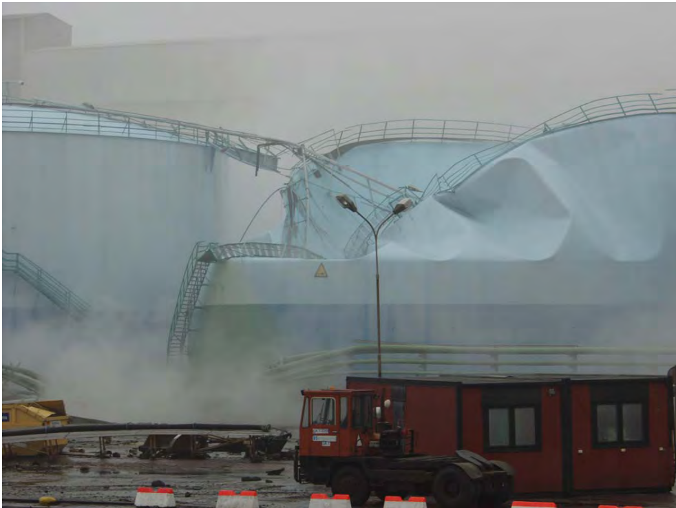
Bild 2. Den havererade svavelsyratanken - bilden hämtad från Statens haverikommissions rapport.
