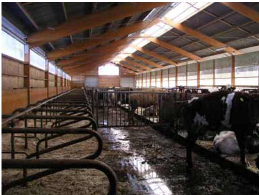
Bild 4: Stallbyggnad med hel öppen långsida. Ljusinsläpp även på motstående sida, i nock och på gavel.
