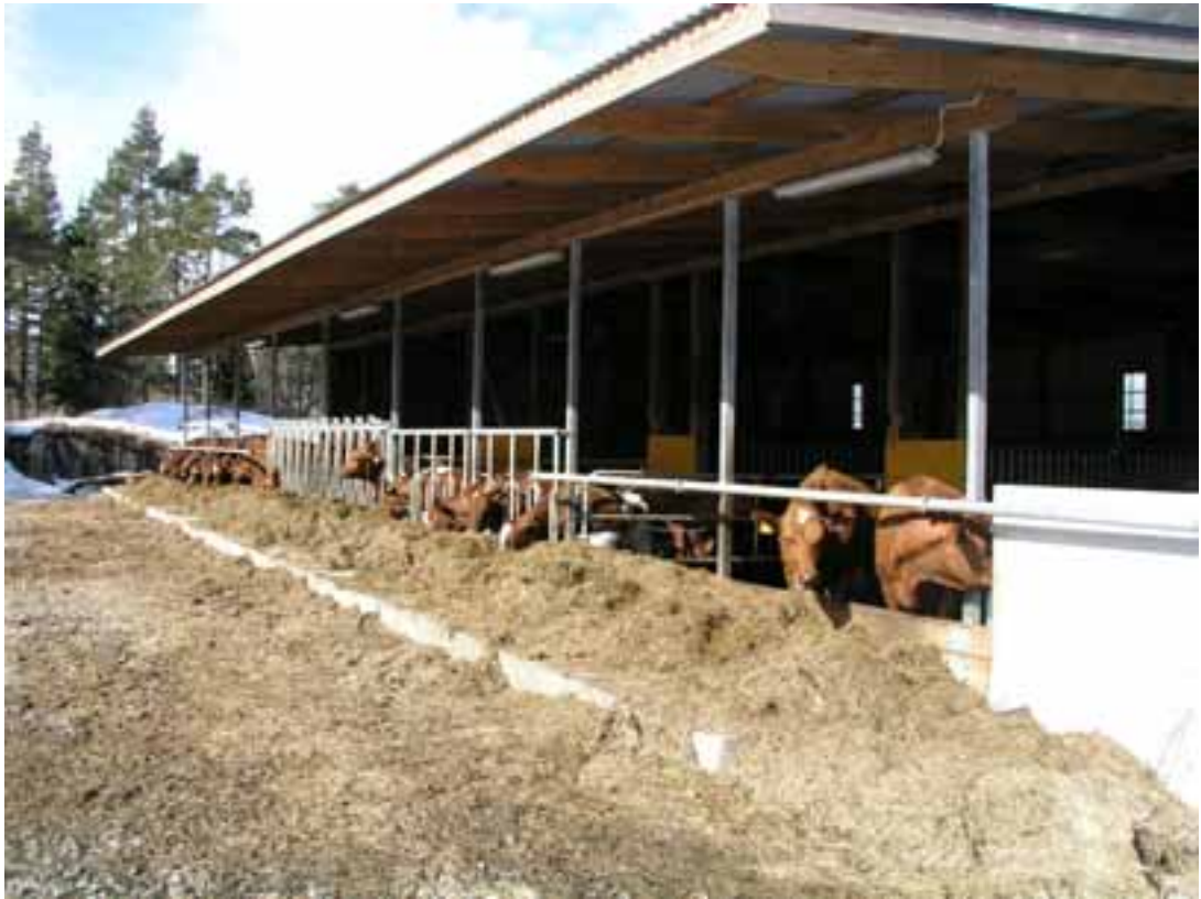
Bild 13: Olika typer av foderbordsinredning. Nackbom, självläsande grindar, ungdjursgrindar och ytterligare en avdelning med nackbom närmast kameran.
