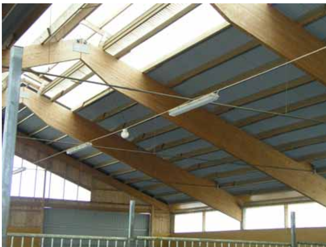
Bild 5: Nybyggnad med frånluft i öppennock. Takmaterialet är kondensskyddad plåt.
