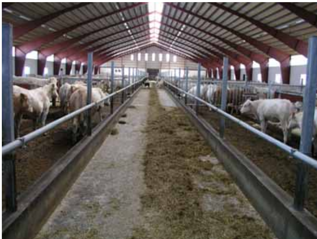
Bild 3: Stall med ljusinsläpp från flera håll och dessutom vid nock, vilket innebär en ljus och behaglig miljö.
