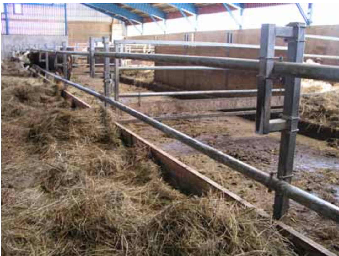
Bild 14: Stall med dubbla nackbommar i dikobesättning. Det är viktigt att bommarna är justerbara så att tryckskador på djuren inte uppstår.
