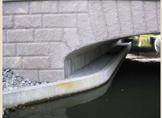
Bilden visar ett exempel på en passage för småvilt anlagd av Vägverket där E4:an passerar över Edsån.
