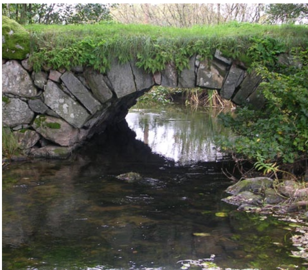
En stenvalvsbro, punkt 10 i Broströmmen. Ett vackert kulturobjekt som inte påverkar vattendragets biologiska mångfald negativt.
