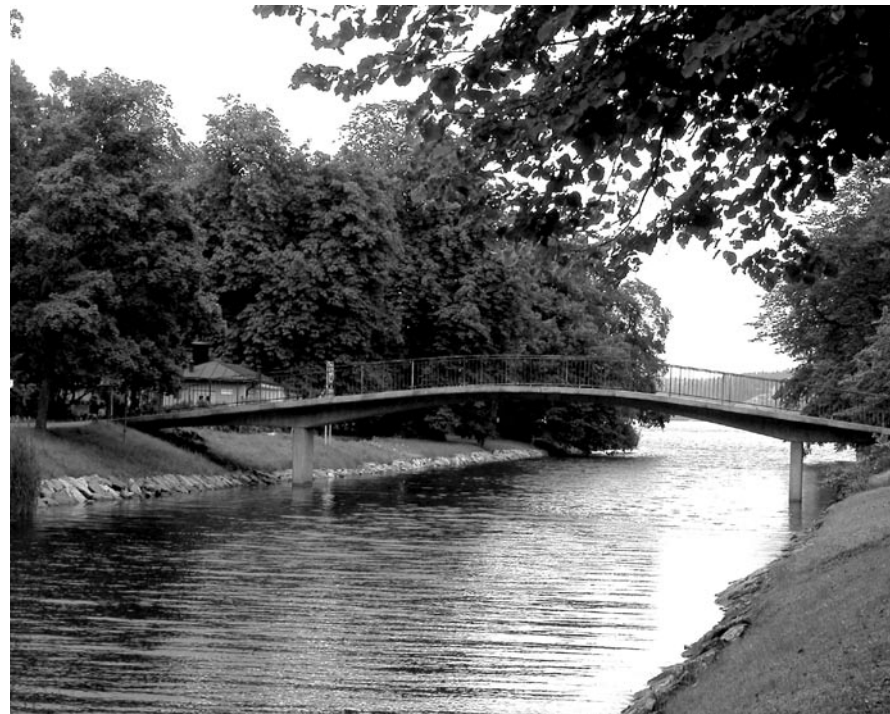
Gång- och cykelbro över Djurgårdsbrunnskanalen.
