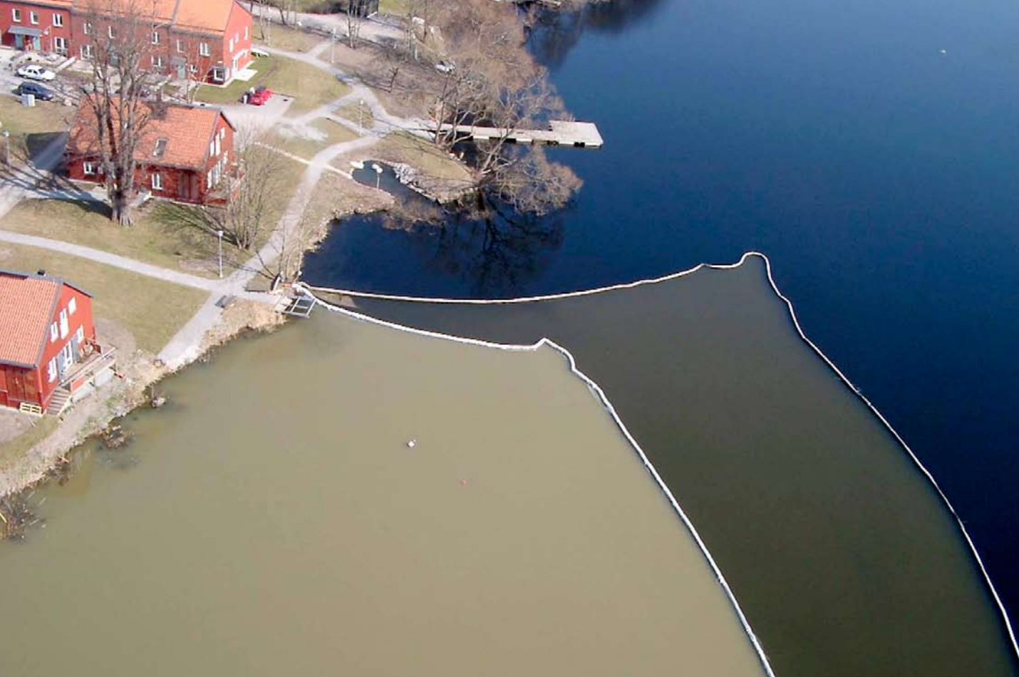
Bilden visar exempel på grumlingseffekten av muddring i vattenmiljön. Notera skillnaden i grumlingsnivå mellan den inre och den yttre skyddsskärmen samt det opåverkade vattnet utanför den yttre avskärmningen. Foto: PEAB.
