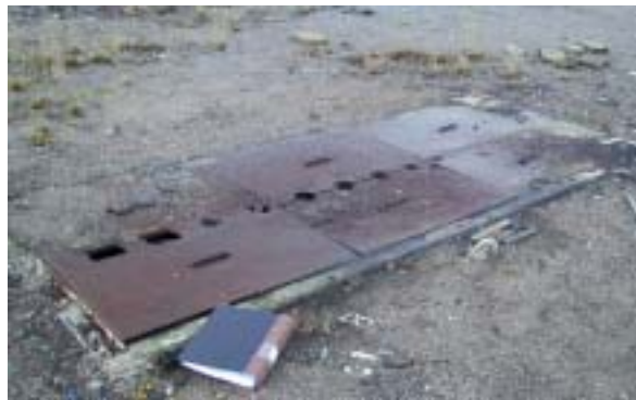
Figur 7: Utlastningsplats för tankbilar. Här mynnar tankningsrör från cisternerna. (Foto: Linda Bengtson)
