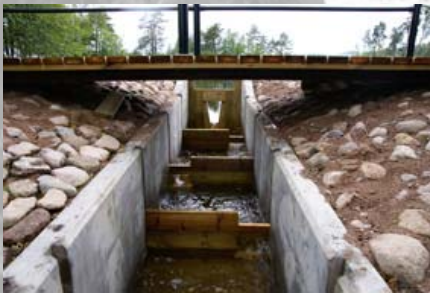
Fiskväg i norra delen av omlöpet i Olstorp. Foto: Urban Hjärte
