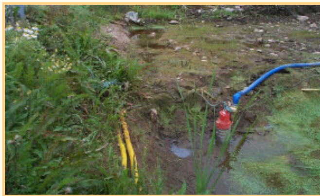
Dräneringspump Brädan 4.
