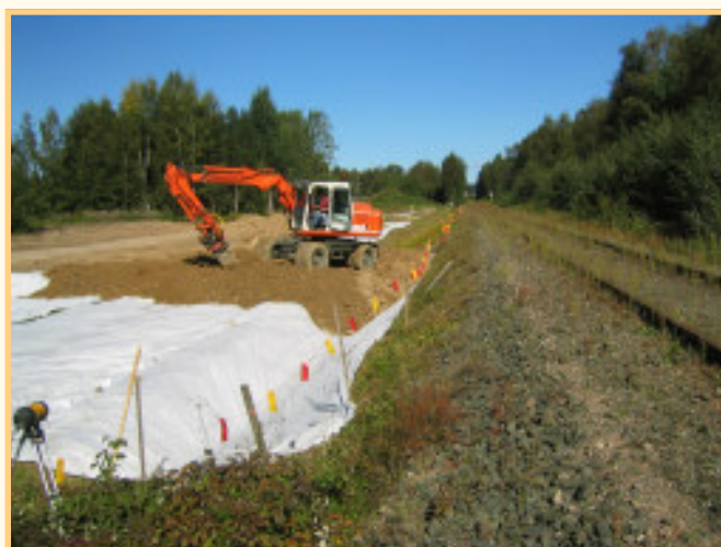
Utläggning av ren morän vid järnvägsdiket.
