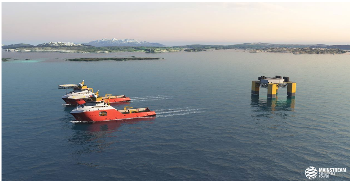
Figur 6-3 Transformatorstationen bogseras ut till vindkraftsparken. Bild: Mainstream Renewable Power
