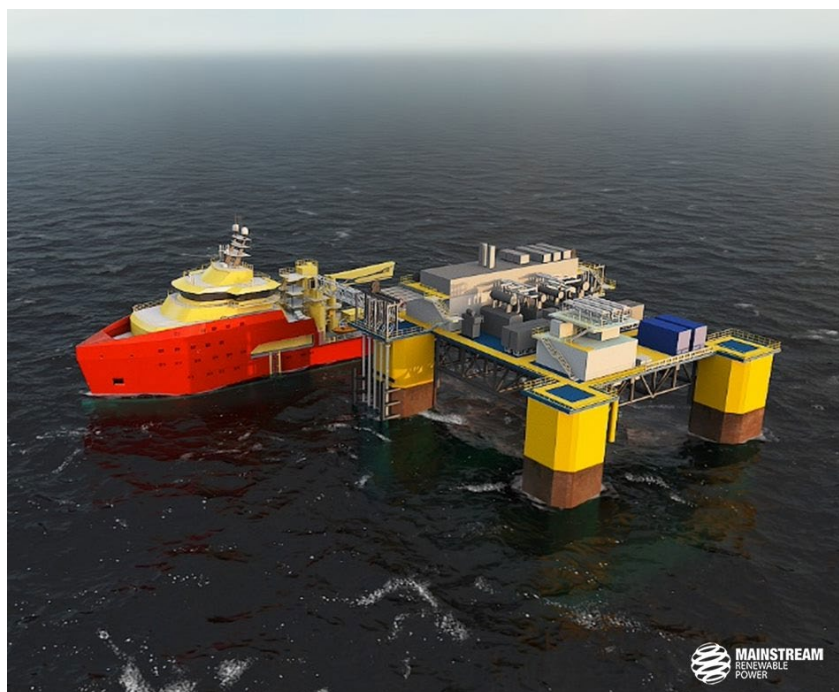
Figur 6-4 En flytande transformatorstation. Servicefartyget (SOV) stannar kvar i parken under hela byggfasen.
