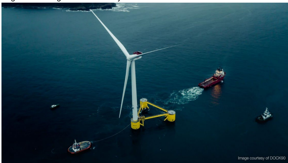
Figur 6-9 Ett vindkraftverk på halvt-nedsänkbart fundament bogseras från integrationshamnen till vindkraftsparken av ankarhanteringsfartyg.
