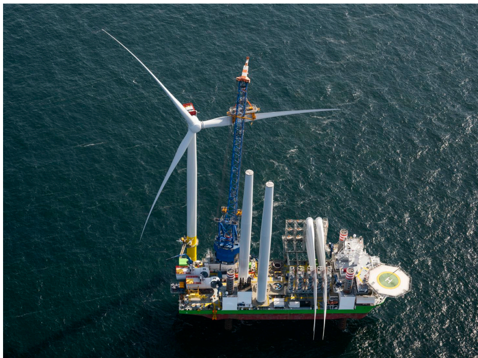
Figur 23. Vid installation av havsbaserade vindkraftverk, används kranbåtar / jack-up fartyg för att placera komponenterna av vindkraftverket på platsen
