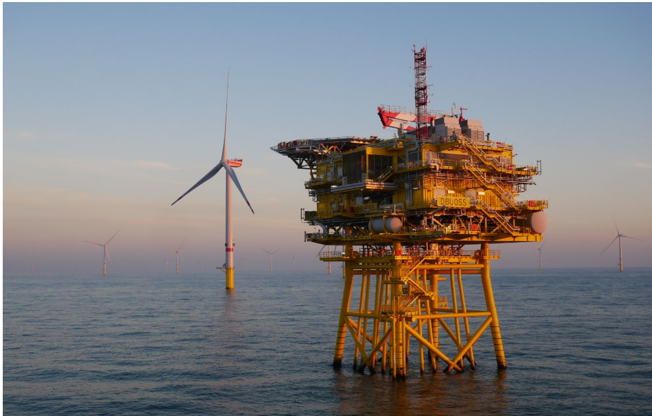
Figur 18. Exempel på transformatorstation på fackverksfundament
