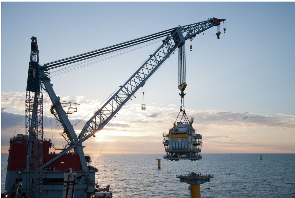
Figur 22. Installation av transformatorstation på monopilefundament där transformatorstationen lyfts på plats. För Västvind Vindkraftpark är fackverksfundament aktuellt för den havsbaserade transformatorstationen.
