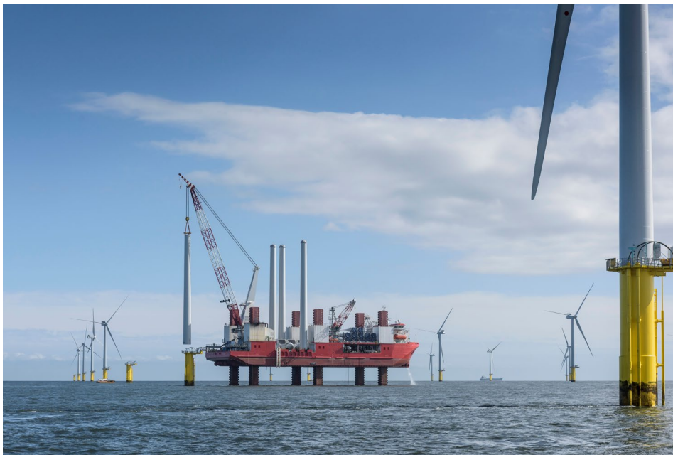
Figur 19. Installation av torn på ett monopile-fundament från ett jack-up fartyg.
