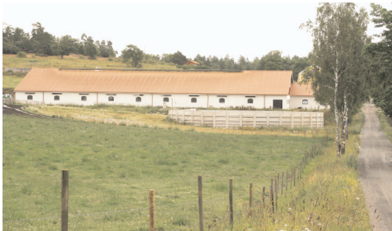
Prefabricerade betongelement ger många nya ladugårdar byggnadstekniskt högvärdiga väggar och ett solitt utseende. Källsåker, Västerviks kommun.
