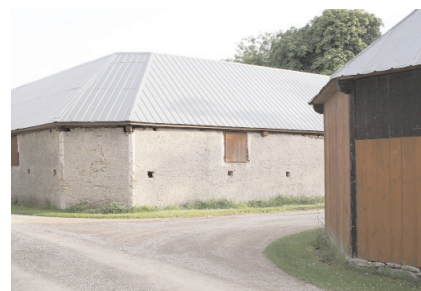
Den dösa öländska ladan är formgiven för att ge vasstaken en ökad livslängd. Denna lada har putsade kalkstensväggar. Djurstad, Borgholms kommun.
