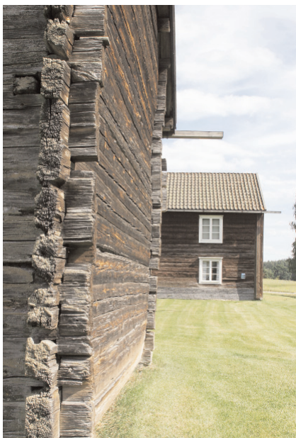
En obehandlad knuttimmervägg ger ögat en svindlande tidsresa ned i medeltiden. Fröreda, Hultsfreds kommun.
