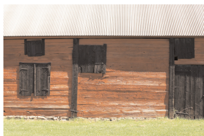
Den öländska skiftesverksladan känns igen på sin kalkstenssockel och sina ofta lite fritt placerade gluggar. Sandby, Borgholms kommun.
