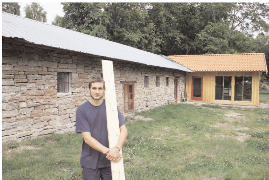
Gustav af Wåhlberg i färd med att färdigställa gårdens spa-anläggning.
