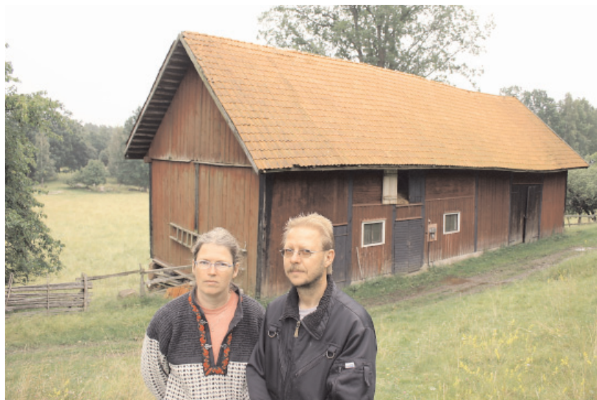
Ann och Peter framför sin ladugård som ska byggas om till restaurang och konferenslokal.
