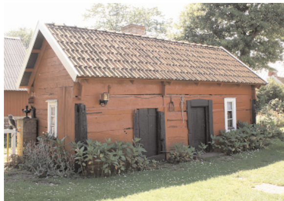
Ytterst få ekonomibygnader finns kvar från tiden före år 1850. Brygghuset på bilden har varit i kontinuerligt bruk i snart tre sekler. Svarteberga, Borgholms kommun.
